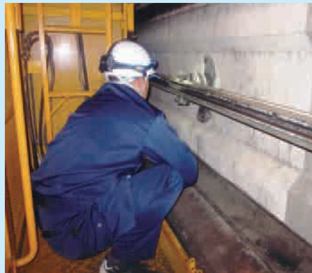
電車線の点検
